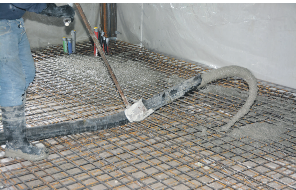
▲ ► Storten van de RAMAC-vloer.
