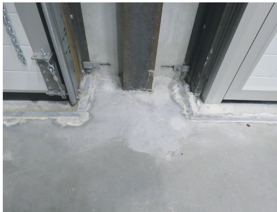
▲ Geen kripscheuren rondom bijvoorbeeld stalen kolommen.
